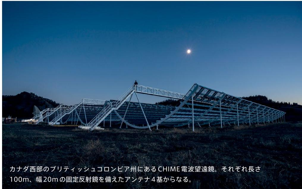
カナダ西部のブリティッシュコロンビア州にあるCHIME電波望遠鏡。それぞれ長さ100m、幅20mの固定反射鏡を備えたアンテナ4基からなる。
