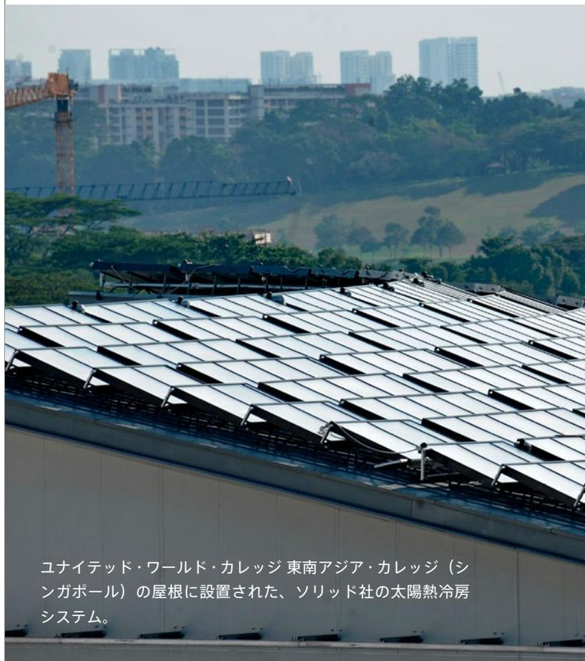
ユナイテッド・ワールド・カレッジ 東南アジア・カレッジ（シンガポール）の屋根に設置された、ソリッド社の太陽熱冷房システム。
